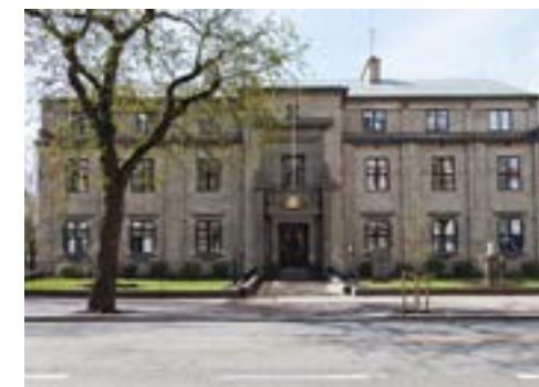
Aars har kjøpt og rennovert Bygdøy Alle 4 som både kontorlokaler og eiernes samlingssted.
